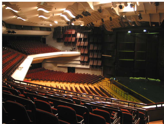
1. ábra: Az eredeti, jól ismert oldalfali terelőrendszer az erősen elnyelő nézőtéri felület elől felfelé irányította a visszaverődéseket.
