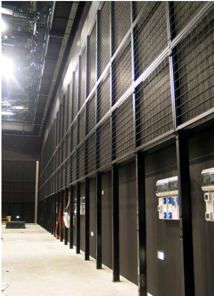
Hangelnyelő burkolat és tartó/védőrács a festett oldalfal előtt.
